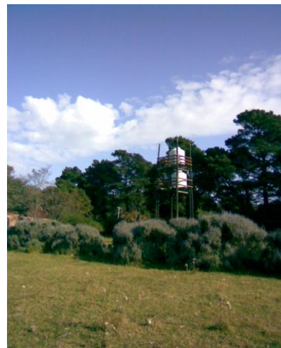
Torre de los tanques de agua
